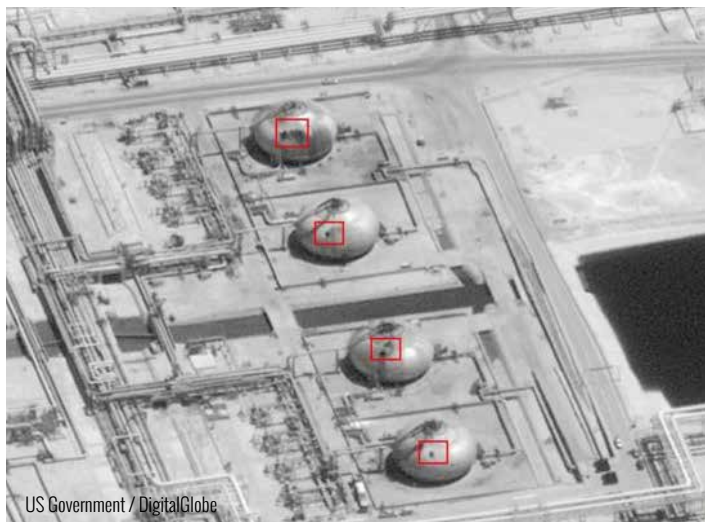
תצלום של הפגיעות המדויקות במתקן הנפט בערב הסעודית לאחר התקיפה האיראנית שם בספטמבר 2019. שלב חדש ביכולות ובתעוזה האיראנית.
